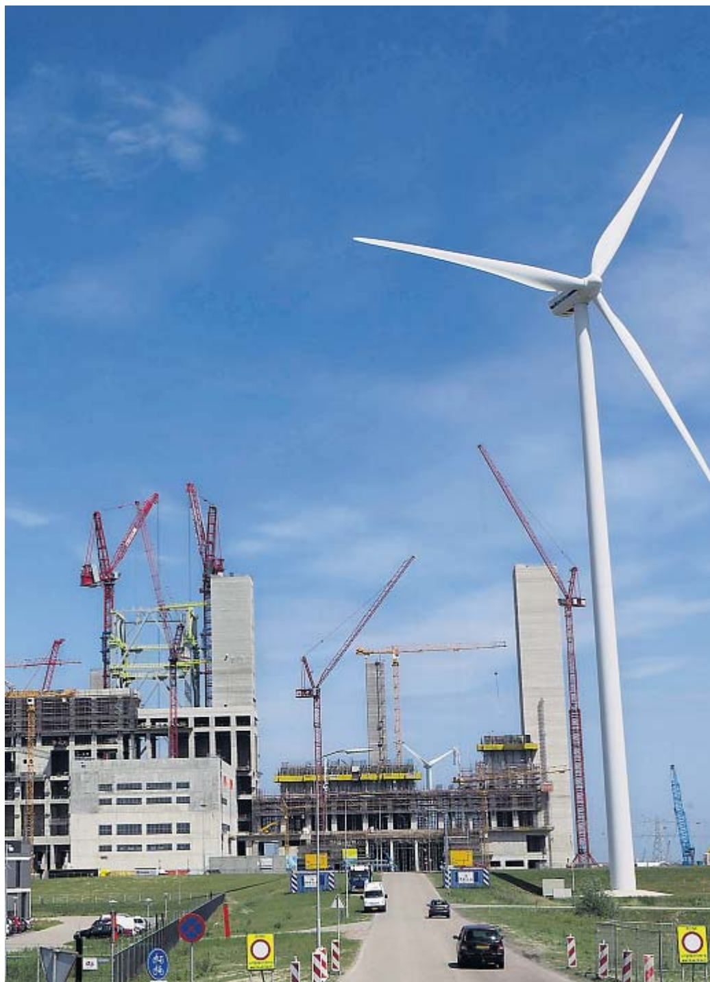
▲ De kolencentrale in de Eemshaven in aanbouw. Foto: Archief Dennis Beek
